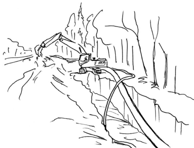
Рис. 4.1.1. Укладка в траншее трубопроводов, смонтированных на поверхности.
