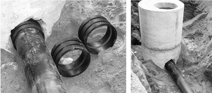
Фото 2.1. Защитные муфты для входа в бетонный колодец
