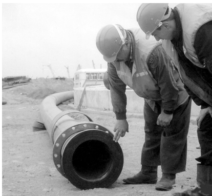
Фото 1.4. Разъемное фланцевое соединение ПЭ труб
